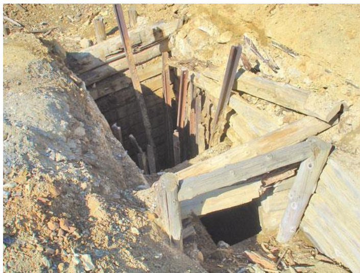
Шахты Лазурского месторождения
