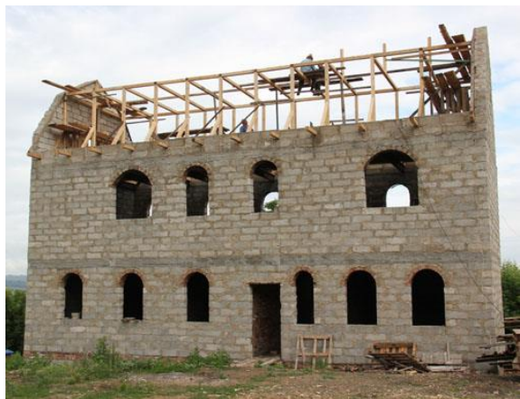
Возведение стен воскресной школы. (Фото Владимира Головчанского).
