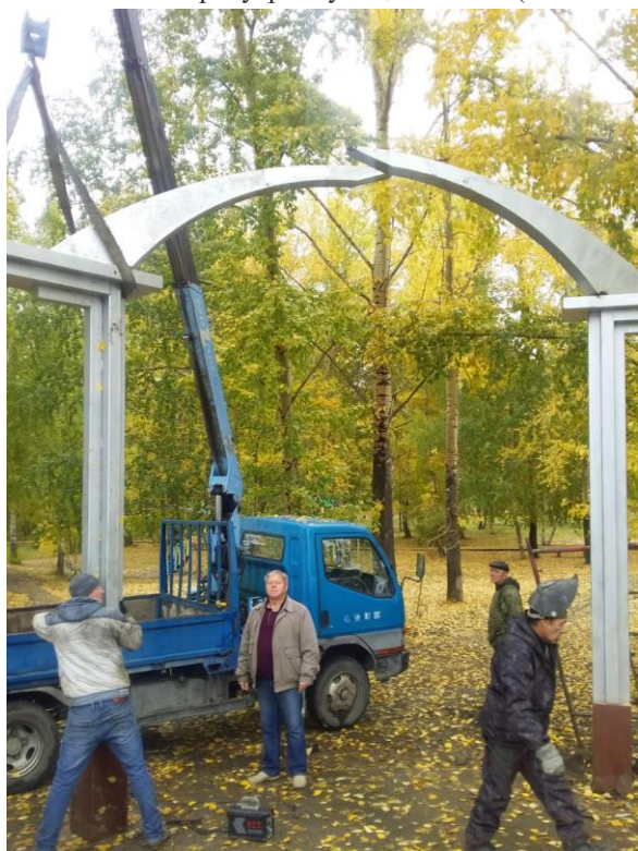
Установка Арки на входе в парк.
