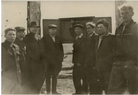
1961 год. Первая, принятая ТП-10 г. Змеиногорск на поселок Красногвардейский. У рубильника В.А.Рязанов, М.В. Вакулин, крайний справа - электромонтер Н.А.Федоров. (Фото из архива ЮЭС).
