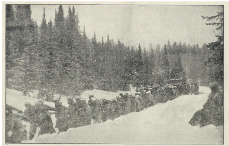
Ревневская каменоломня. Перетаскивание каменной заготовки 250 рабочими для саркофага Александру II в марте 1889 года. (Изображение из открытых источников)
