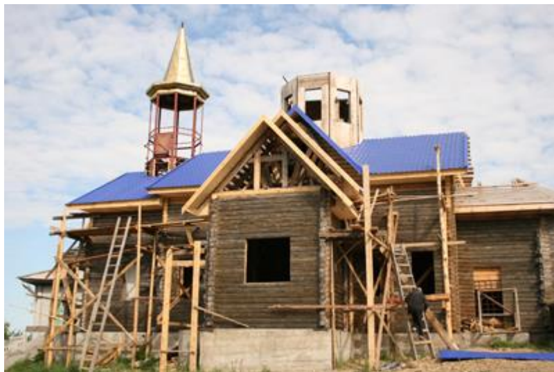
Момент установки каркаса будущей колокольни. (Фото Владимира Головчанского).
