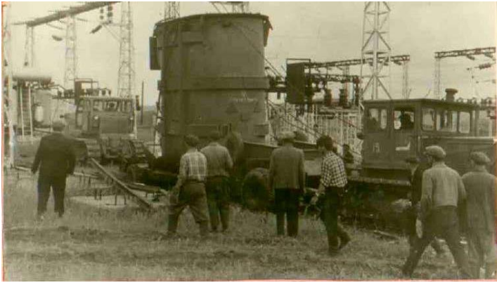
1968 год. ПС Змеиногорская. Установка Т-2. (Фото из архива ЮЭС).
